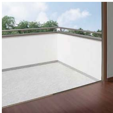
施工前の無機質なバルコニー
