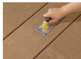
▲長尺方向に沿って一方向にサンドペーパーでこすってください。
