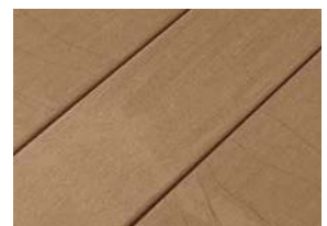
▲全体をぼかすようにこするときれいに補修できます(中央部)。
