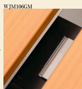
次のデッキ材を取付金具に引っ掛ける。
